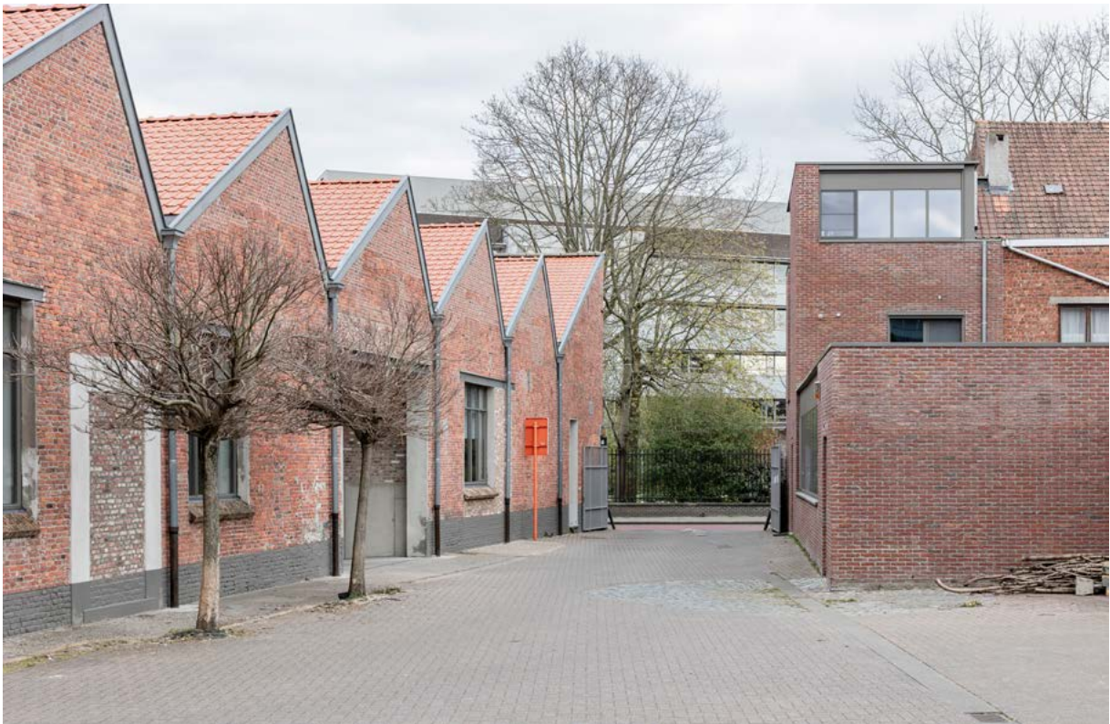
Buitenzicht van voormalige textielfabriek Florida in Gent © Foto Alexander Dumarey
