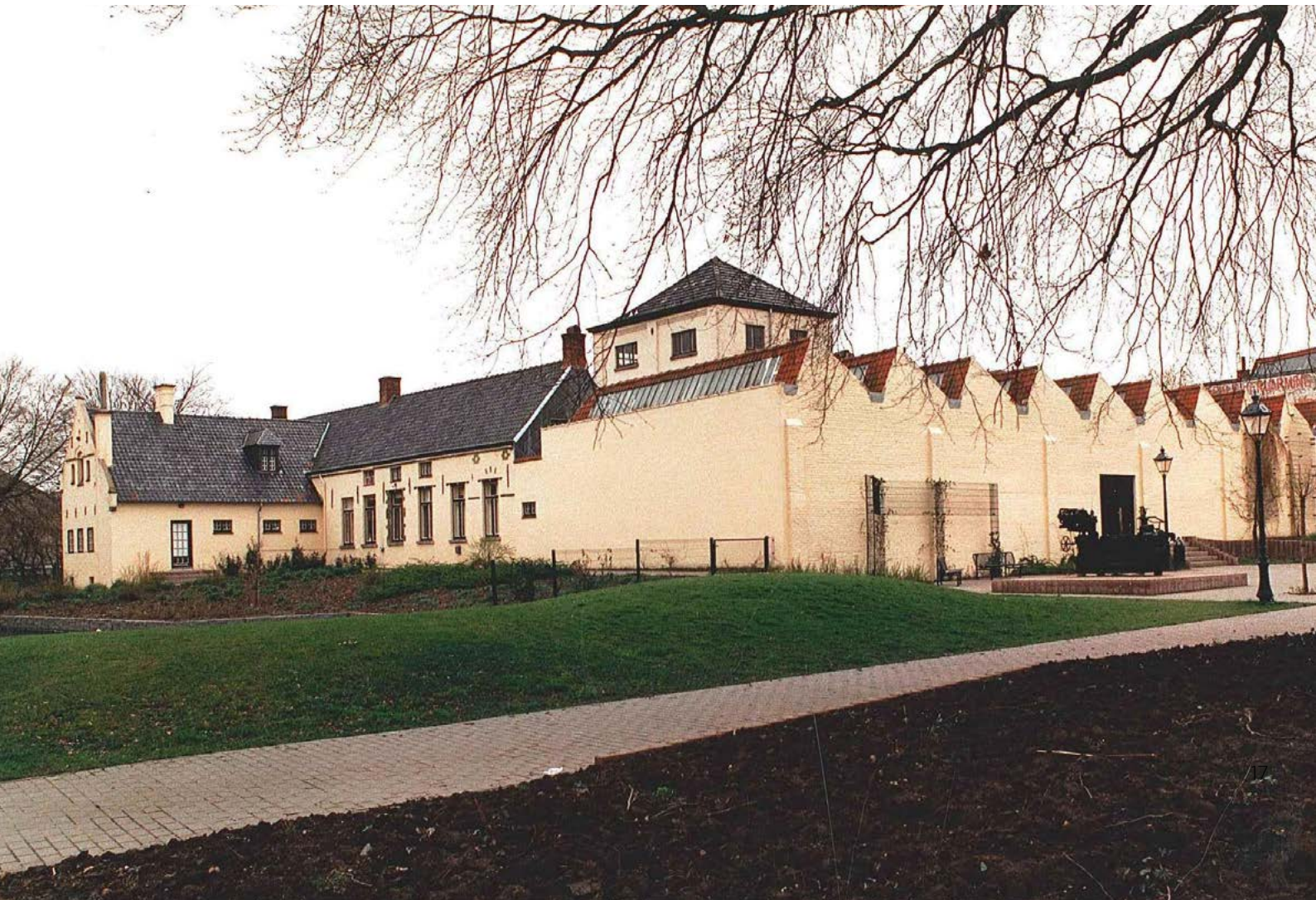
Hoge Mote te Ronse, voormalige weverij en textielfabriek Cambier-Robette, id: 28533. Het gebouw is beschermd als monument en stadsgezicht. Op heden wordt hier het MUST gehuisvest. Foto: Inventaris Onroerend Erfgoed
