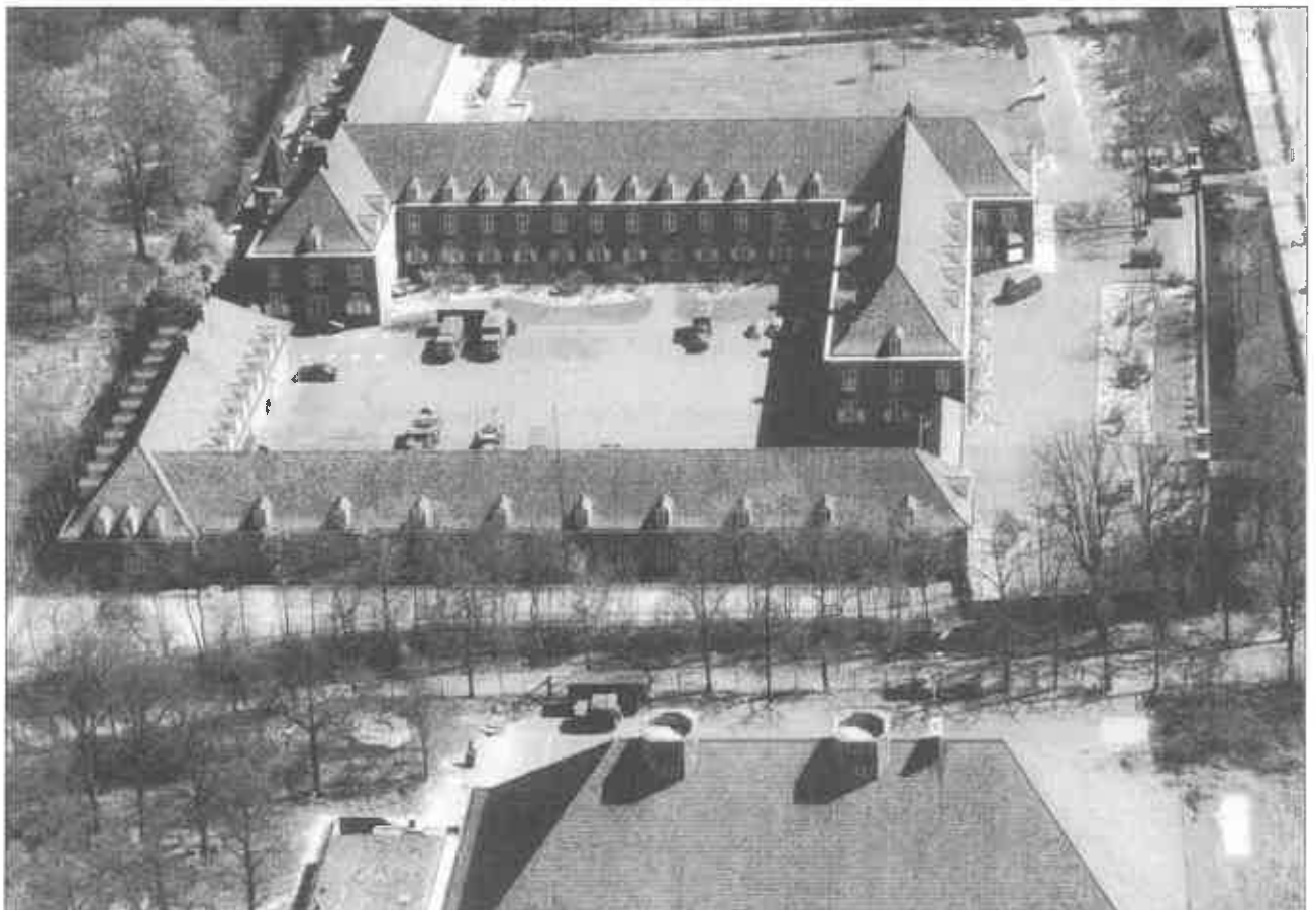
Luchtfoto van de kazerne, gezien vanuit noordwesten. Op de voorgrond de grote bunker, die onder andere was bedoeld als noodonderkomen voor Reichskommissar Seyes-Inquart en het door hem geleide bestuursapparaat. De foto is uit 1955.
