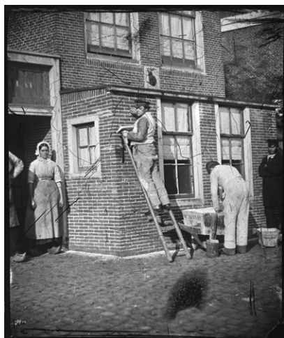
Metselaars aan het werk in de Bokkinghangen (Westelijke Eilanden) Jacob Olie - Stadsarchief Amsterdam (1862)
